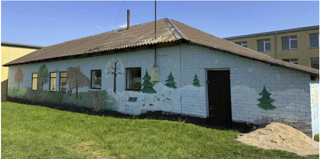
3 pav. Projektuojamas rekonstruoti pastatas yra plytų mūro su šiferiu dengtu stogu
